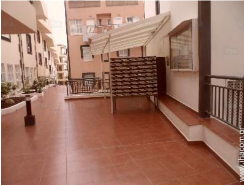
ταράτσα στη στέγη
